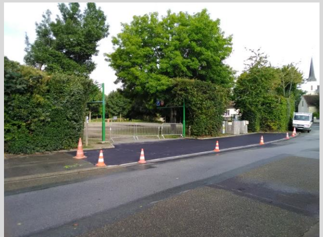
Réfection du trottoir à l'entrée du parc
